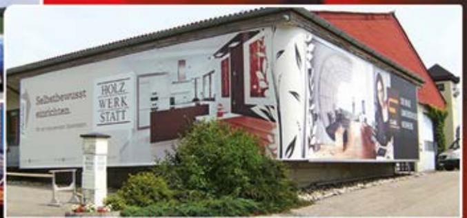
Fassadengestaltung mittels 4c-bedrucktem Mesh im Gesamtformat von 24 x 3,7 Metern, wobei die Rückseite in Schwarz bedruckt wurde, damit eine ungehinderte Durchsicht von innen möglich ist.
